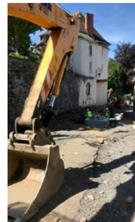
Travaux rue des Pradals Installation du déversoir orange - juin 2020
